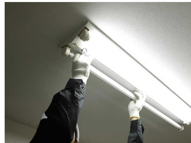
LED蛍光灯の設置工事
