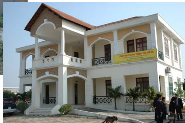
(工業団地管理事務所)
