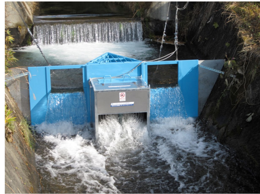
低落差型流水式小水力発電装置。複数の水路に連続設置することで、分散型の電源インフラとしても機能する。災害などの非常時には、緊急電源として転用することも可能である。
