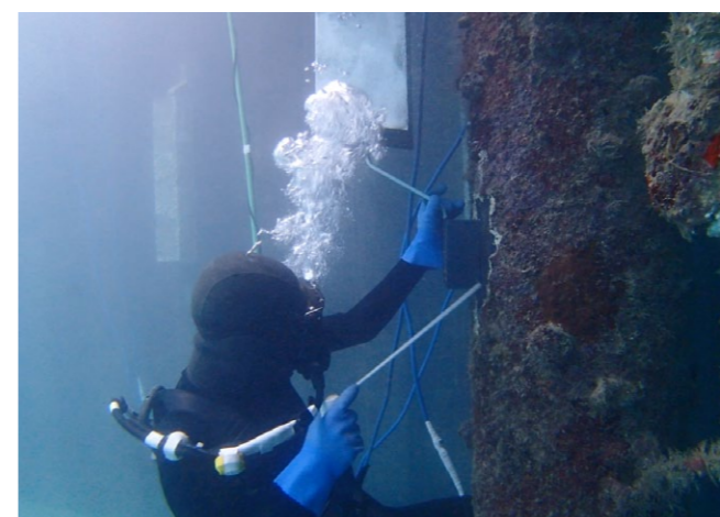
ダイバーによる電気防食用アルミニウム合金流電陽極の水中溶接状況。海洋鋼構造物と電氣的に導通させることによって、同構造物の腐食を防いでいる。
