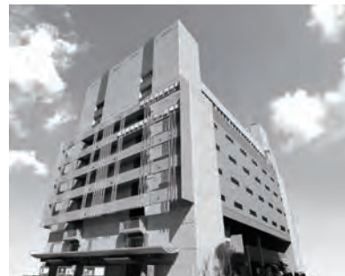
東京都立産業貿易センター台東館
