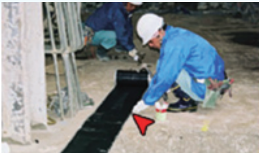
耐圧盤工区境用の取り付け
