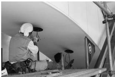
照明器具取付工事
