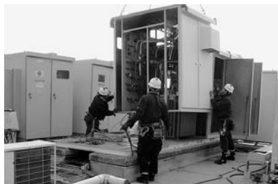
キュービクル式高圧受電設備の交換
