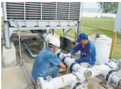
配管にデジセイバーを設置している様子。現地での技術指導などは代理店に任せている
