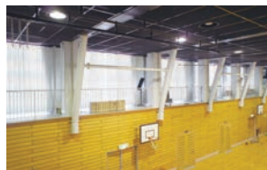
4: 吸音ブラインド 某小学校 体育館
