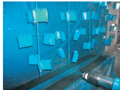
静電塗装作業
