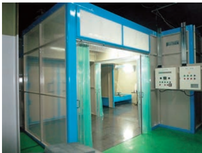
クリーンルーム(手吹き塗装)
