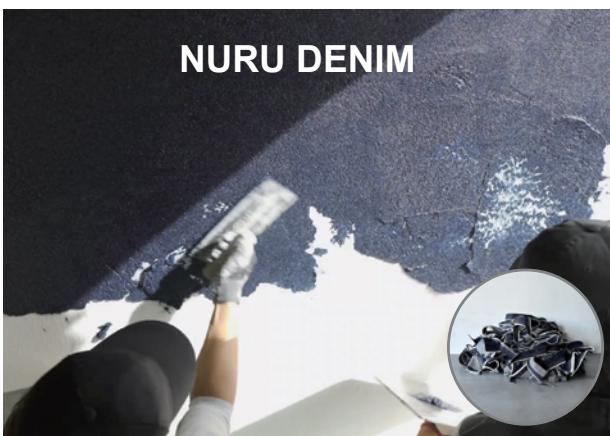
NURU DENIMは、デニムの端材を粉碎し左官材へアップサイクルして作られ、吸放湿性に優れた、独自の質感をもつ商品です。国内のデニム工場から排出される端材の課題解決の取り組みから開発されました。接着剤を使用していないため古くなったら水をかけ再度練り直すと、また左官材としてよみがえります。「排出される端材→アップサイクル→リユース」というきれいな循環が可能です。
