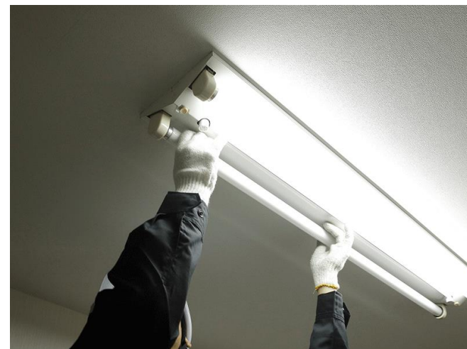
LED蛍光灯の設置工事
