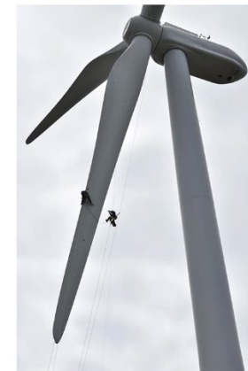
日立造船の風力発電で作業をする特殊高所技術の作業員=秋田県由利本荘市、星野英三雄撮影
