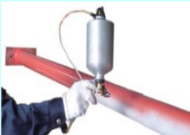
配管等の防さび対策
