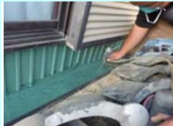
構造物の補修
