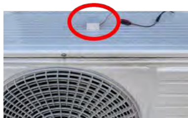
空調室外機の振動測定状況
