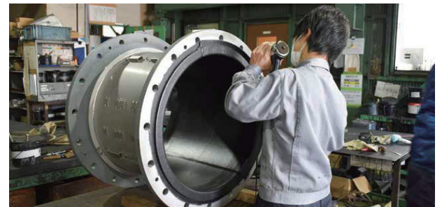
ゴムライニング作業の様子
