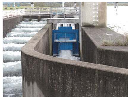
水力発電機ストリーム
