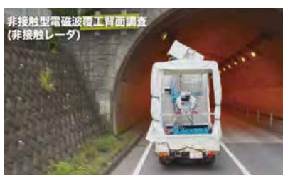
走行診断状況 (非接触型電磁波覆工背面調査)
