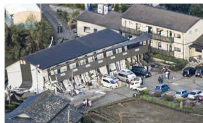
1階が崩壊したアパートの様子(写真:共同通信社)
