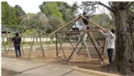
組立ての様子
