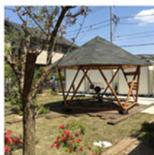
東屋 屋根を葺いた東屋
