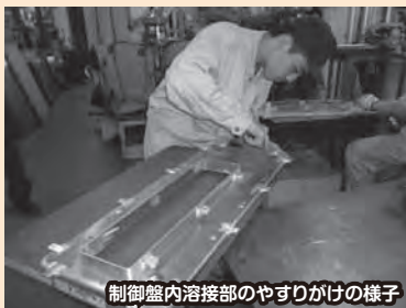
制御盤内溶接部のやすりがけの様子
