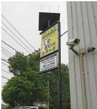
有明電装EL事業部が専用プロジェクトのもとに商品化を進めてきた“大型避難誘導標識”は、低消費電力の最有力発光体である“無機EL発光体”と、究極のエコパワー「太陽エネルギー」を組み合わせることで完成した最新の「ソーラー式無停電型避難誘導システム」です。当該プロジェクトによる商品化は、東京都が先進的防災技術の普及による都市防災力の向上と、産業の活性化を図ることを目的として支援する“先進的防災技術実用化支援事業”の対象事業です。
