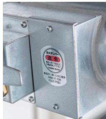
同社のダンパーには建築基準法施行令に適合していることを示す「自主適合マーク」が貼られている。
