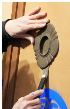
修復のため襖の引手を外す
