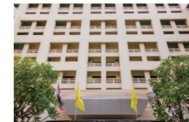
TRINCバンコクデモセンター
