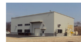
会津若松工場(河東町工業団地)
