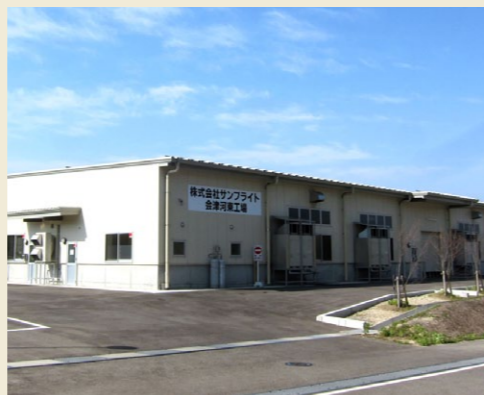
会津河東工場
