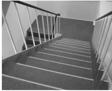
〈明視下〉 「蓄光機能」と「防滑機能」を組み合わせせた階段
