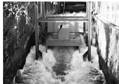
水路に設置された流水式小水力発電装置
