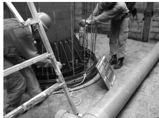
現場での施工風景
