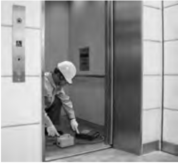
エレベータ用振動測定装置の使用風景
