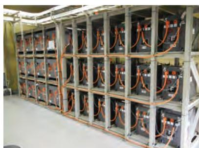
複数の車載中古電池を組み合わせ、定置用蓄電システムとして再利用。風力発電など再生可能エネルギーの普及に役立っている
