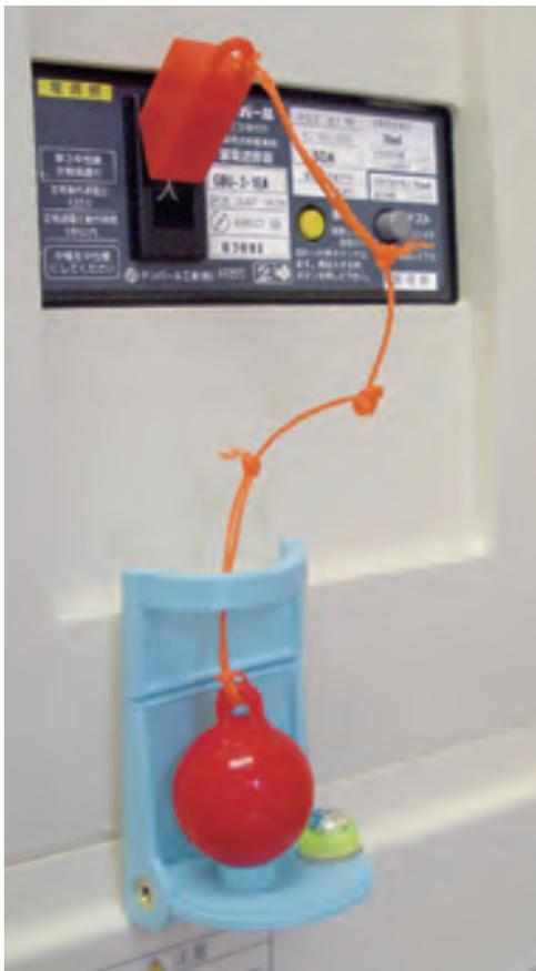
大地震の出火原因で約6割が通電火災と言われています。震災直後は無事でも、通電火災による時間差の火事に巻き込まれる可能性が大いにあります。このことから、消防署や電力会社等では避難の際は必ずブレーカーを落とす様指導しています。ブレーカーのスイッチを落とす事で通電火災による二次災害を100%防げるのです。
