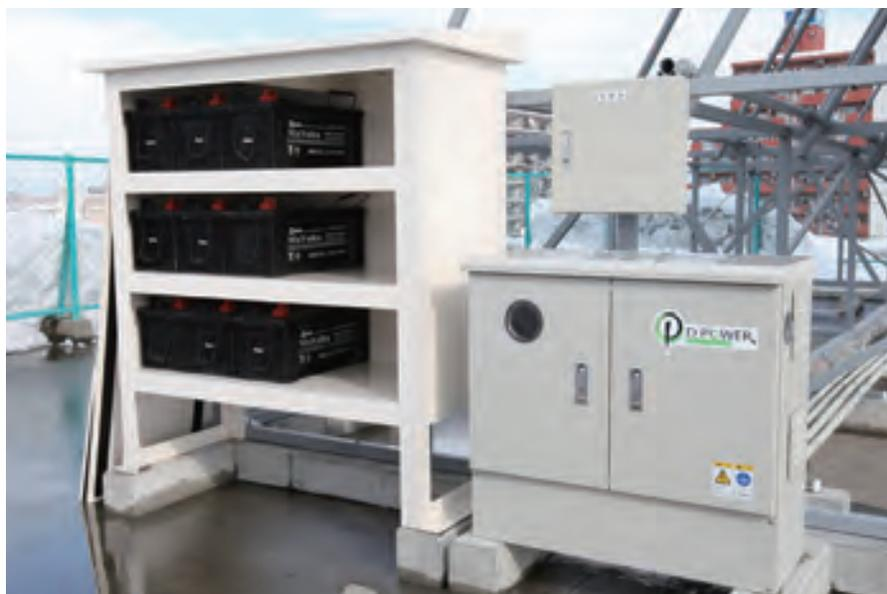
Dパワーは非常用・節電用どちらにも対応可能な蓄電システムです。業務用・一般家庭用等の環境を問わず設置ができます。信頼性の高い鉛電池を使用する事で、価格を抑えながら大容量を実現。また、深夜電力と太陽光発電からの充電だけではなく、風力・小水力発電からの充電も同時に行うことができるハイブリット型特別仕様も可能です。
