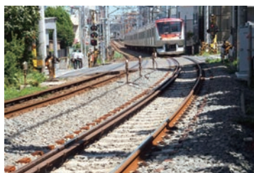
都内私鉄軌道(自由が丘近辺)に座屈防止板を敷設
