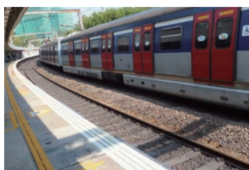
香港地下鉄公団 大学駅に敷設
